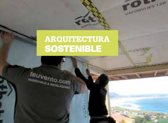
TRASDOSADO DE PLADUR CON CINTA ESTANCA EN UNA VIVIENDA PASSIVHAUS CON ESTRUCTURA DE MADERA.
