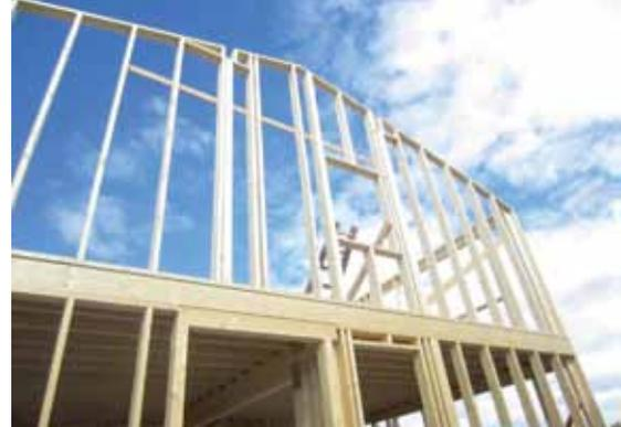
BIOCONSTRUCCIÓ PAPIOL. LEVANTANDO UNA VIVIENDA CON ESTRUCTURA DE MADERA.
