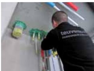
HERMETIZADO DE TUBOS ANTES DE LAS PRUEBAS DE ESTANQUEIDAD EN UNA VIVIENDA PASSIVHAUS.
