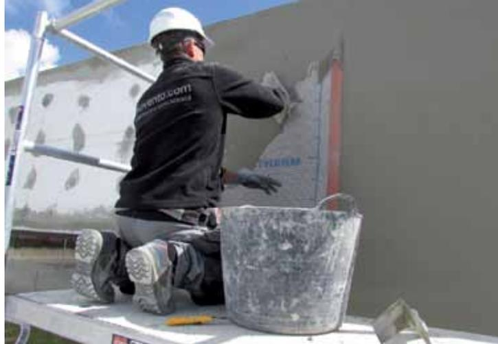
ACABADO SATE EN UNA VIVIENDA PASSIVHAUS DE HORMIGÓN Y TERMOARCILLA.
