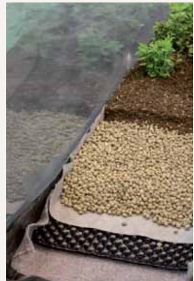
El drenaje constituye un elemento importante en la conservación y durabilidad de las cubiertas ajardinadas y de los jardines. La utilización de **ARGEX** permite un drenaje rápido del exceso de agua debido a los pequeños espacios que existen entre las bolas de arcilla y evita que el agua se acumule en el subsuelo, lo que ayuda a las raíces de las plantas a respirar.
