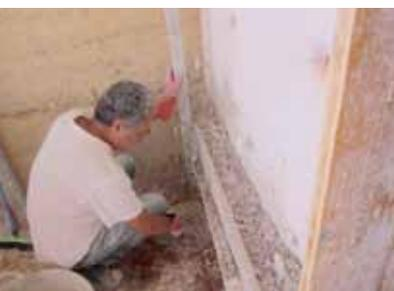
BIOCONSTRUCCIÓ BADALONA. EJECUCIÓN DE UN SATE DE CAL Y CÁÑAMO.
