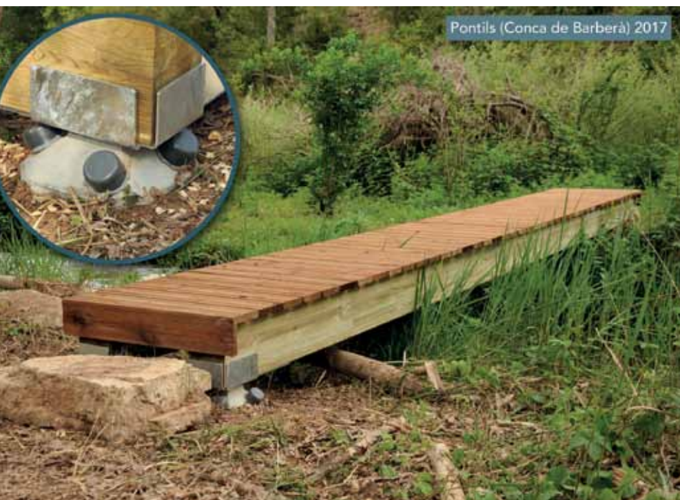
Cimentación para escuela de Surf en la playa de Hossegor, Biarritz, Francia. (Imagen superior). Cimentación para colocación de pasarelas en ruta senderista en un entorno protegido. (Imagen inferior). Cimentación del edificio Möbius en San Sebastián. (En la primera página).
