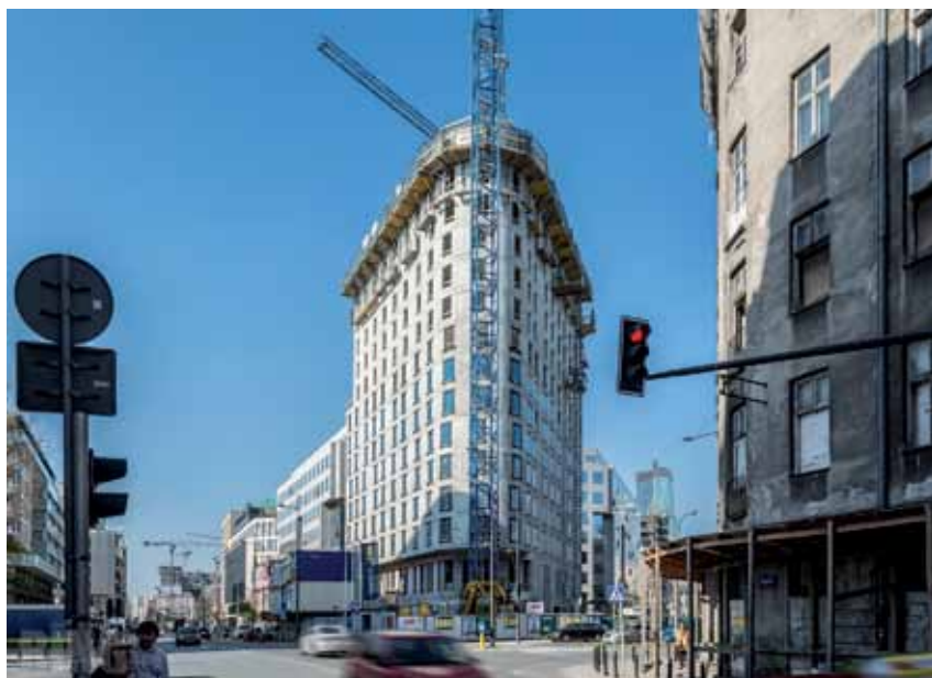
Construcción del nuevo Hliday Inn en Varsovia, Polonia.
