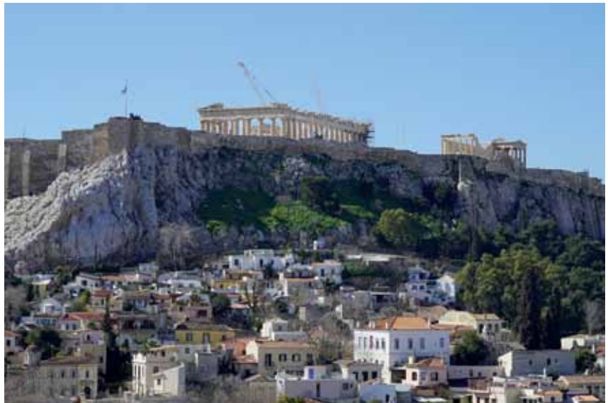
En Grecia se lanzó un programa para subvencionar el reemplazo de antiguas calderas de petróleo con gas natural en edificios privados, que cubrió hasta el 60% del costo total.
