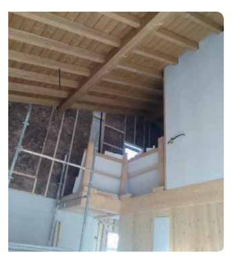
taciones. Interiormente lleva una membrana inteligente retardante de vapor y un trasdosadoaislado con el mismo material de 5 cm que sirve a su vez como paso de conducciones eléctricas y de fontanería. El recubrimiento final interior, característico de la empresa palentina, es un tablero Fermacell de fibra y yeso de alta densidad
