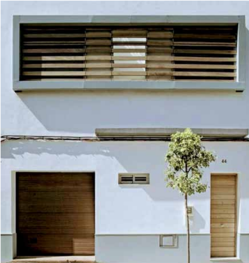
La fachada tiene como resultado una magnífica solución e integración en el entorno. Materiales con acabados sencillos, donde se destaca la utilización de estuco de cal blanco siendo este material autóctono.
