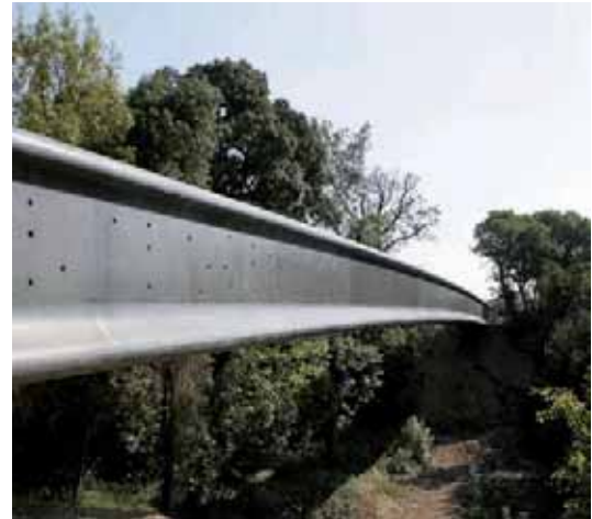
Figura 2.- Pasarela en Francia, resuelta con un elemento de hormigón prefabricado de muy alta resistencia.
