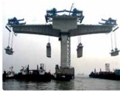
Izquierda: Figura 2.- Construcción de un puente off-shore mediante el empleo de cajones prefabricados de hormigón para la formación del tablero. Derecha: Figura 3.- Fachada de hormigón arquitectónico en la Universitat Rovira I Virgili
