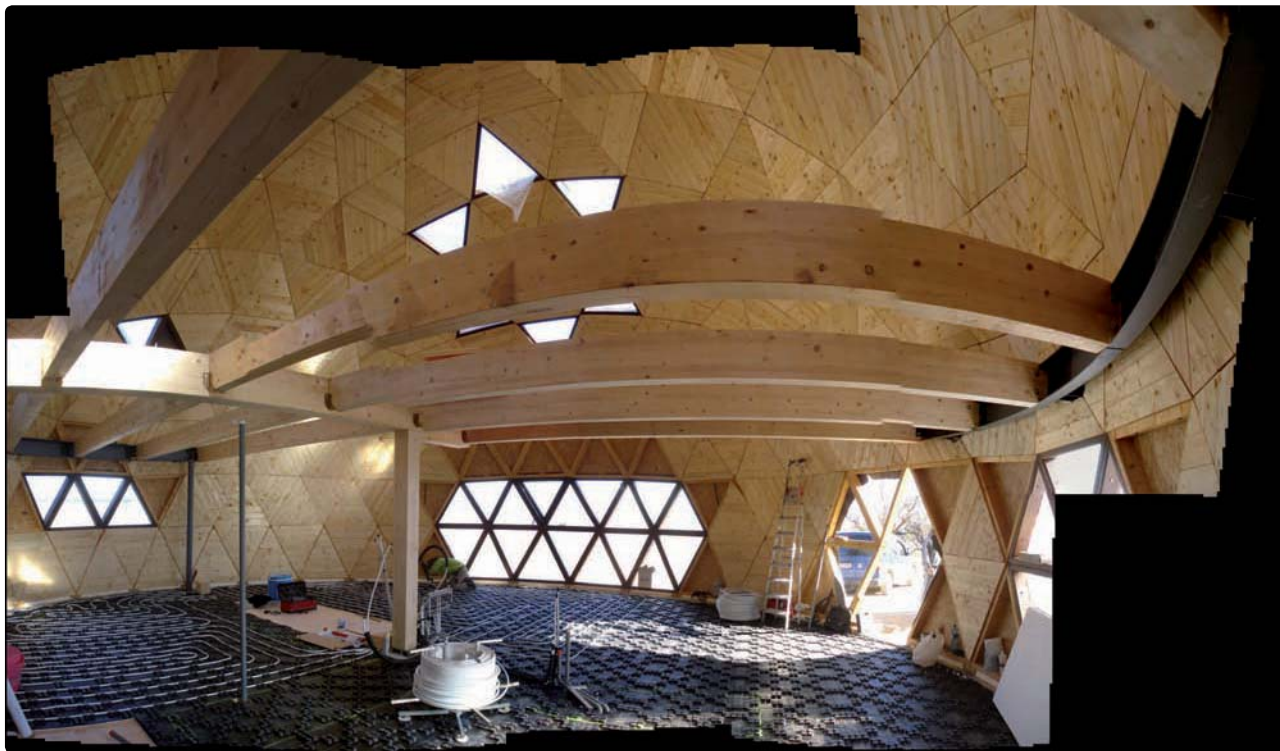
↓ Vista interior con la estructura del atillo y colocación de suelo radiante (obra Yecla).
